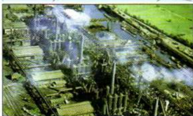
Металлургический комбинат в Дуйсбурге (Германия)
